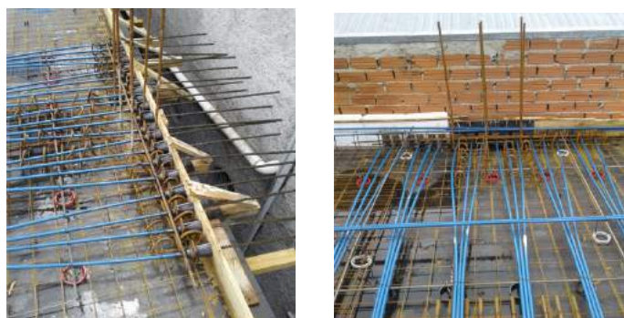
Figura 2 - Dispositivos de ancoragem (esquerda) e cordoalhas transversais e longitudinais (direita)
