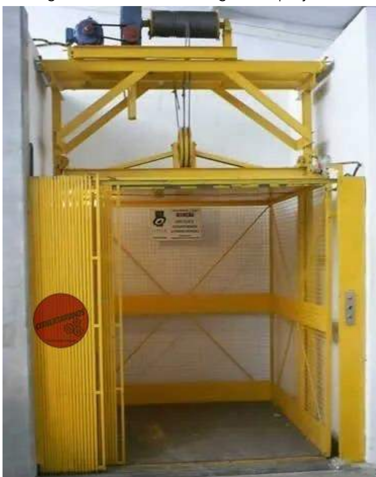
Figura 4 - Elevador de carga a ser projetado
